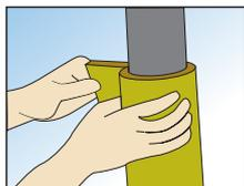
Fijar el fieltro a la tubería, presionando ligeramente para asegurar la perfecta adherencia.
