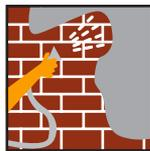
**Para el acabado raspado:** Aplicar el mortero manual o mecánicamente.
