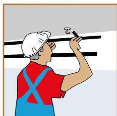
Se fija el perfil primario a las suspensiones y entre ellos, por el sistema de vallo-neta.
