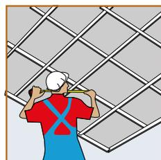
Comprobar la correcta colocación a escuadra de toda la estructura de perfiles.
